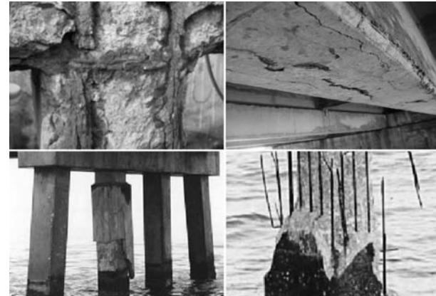
图 4 海岸工程钢筋混凝土结构的腐蚀现象<sup>[6-8]</sup>
