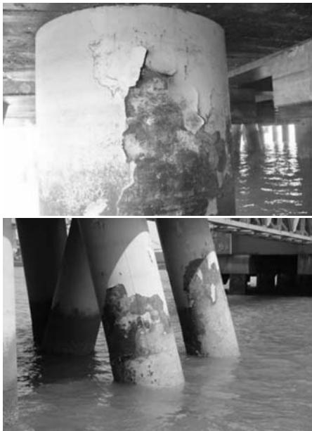
图 5 浪花飞溅区的腐蚀现象<sup>[6-8]</sup>Fig. 5 Corrosion on splash zone<sup>[6-8]</sup>
