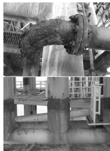
图 3 海洋平台结构中的腐蚀现象<sup>[5]</sup>
