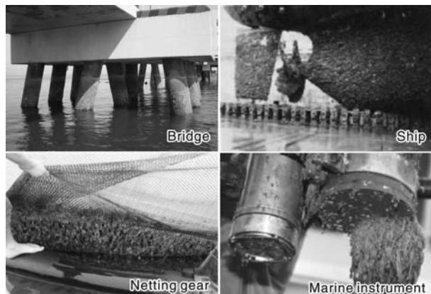
图 6 海洋结构表面的海生物污损现象<sup>[9]</sup>Fig. 6 Biofouling on marine structure surface<sup>[9]</sup>
