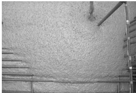
图 4 自密实混凝土的浇筑
