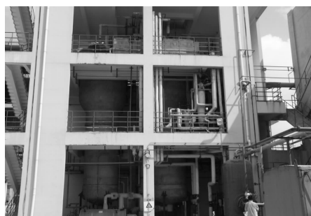
图8 200~500 t/a规模的纳米 \text{SiO}_2 气相燃烧工业化试生产装置
