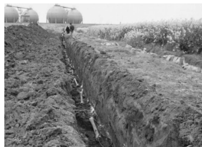
管线阴极保护技术施工
