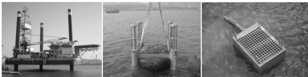
安装外加电流阴极保护成套设备的 中油海8号平台
