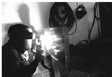
图3 铝合金船舶采用钨极交流氩弧焊现场焊接图
