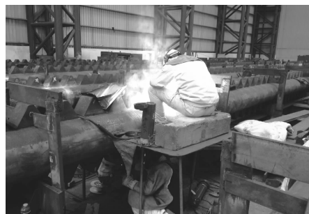
图 1 自升式平台桩腿齿条板焊接现场
