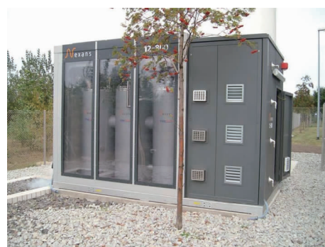
图3 德国 Nexans 制造的 12 kV/800 A 的 SFCL, 安装在德国 Boxberg 配电站挂网运行 [24]
