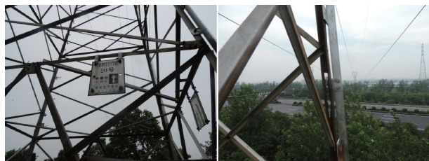
图 1 输电线路塔架横担结构腐蚀穿孔照片
