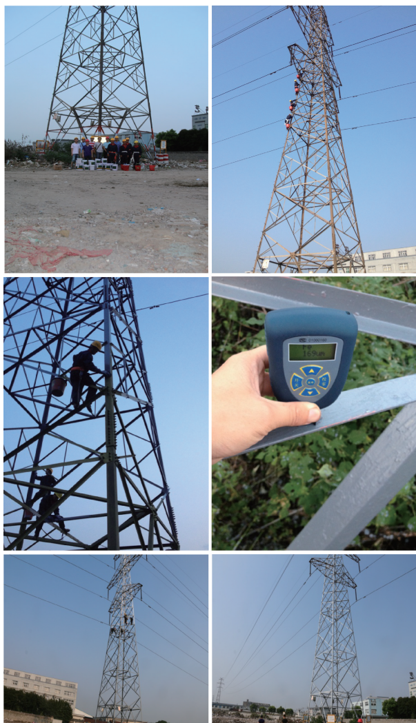
图8 石墨烯基重防腐涂料现场施工照片, 施工时间为2016年7月
