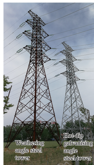
图 5 安徽阜阳沙河-东庄 220 kV 线路冷弯耐候角钢塔
