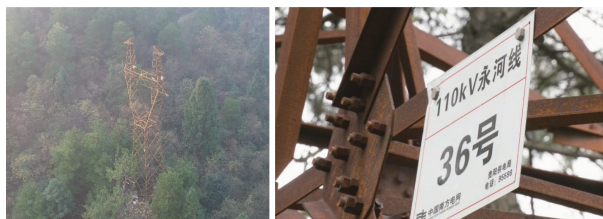
图 7 110 kV 永温-干线热轧耐候角钢塔
